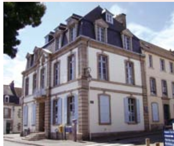
L'ancienne mairie, un bâtiment à beau potentiel
