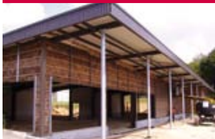
Le Magasin Bio en cours de construction à Kériolet
