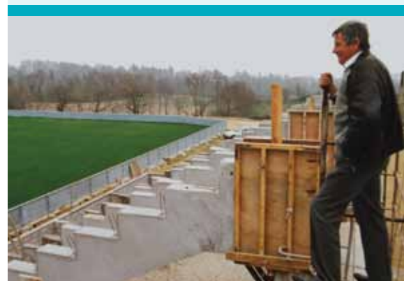
Guy Piriou lors de la construction de la tribune principale du nouveau stade situé à Kerampéru.
