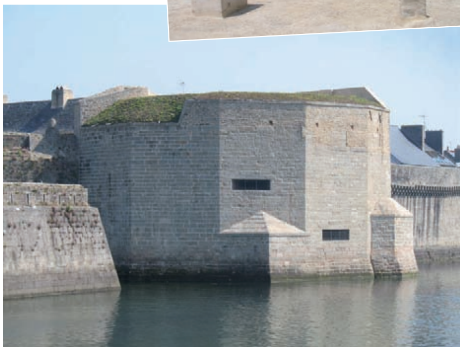
Une réhabilitation minutieuse.
