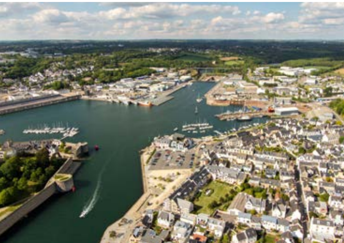
Des installations portuaires à moderniser.
