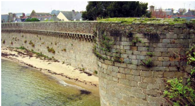
La tour du Maure, objet de travaux urgents cette année.
