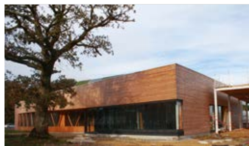
La future pépinière d'entreprises, un chantier mené à bien par CCA
