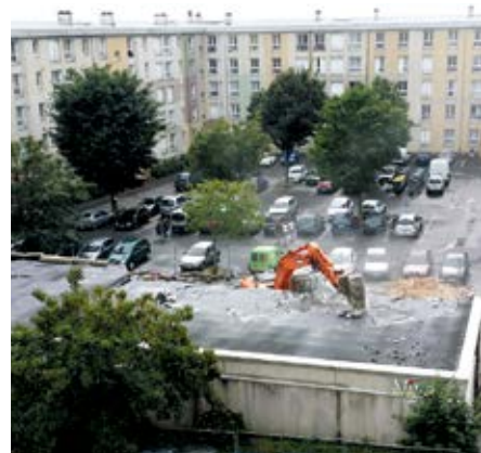
La déconstruction de la supérette.
