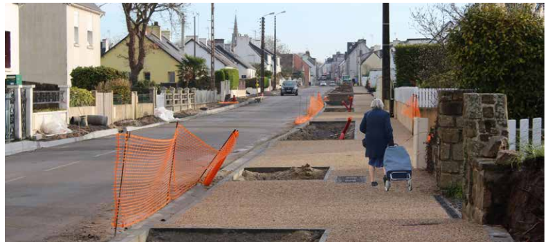
DÉCEMBRE Rue de Lanriec : giratoires, plateau ralentisseur, trottoirs... des aménagements d'envergure pour la sécurité de tous.
