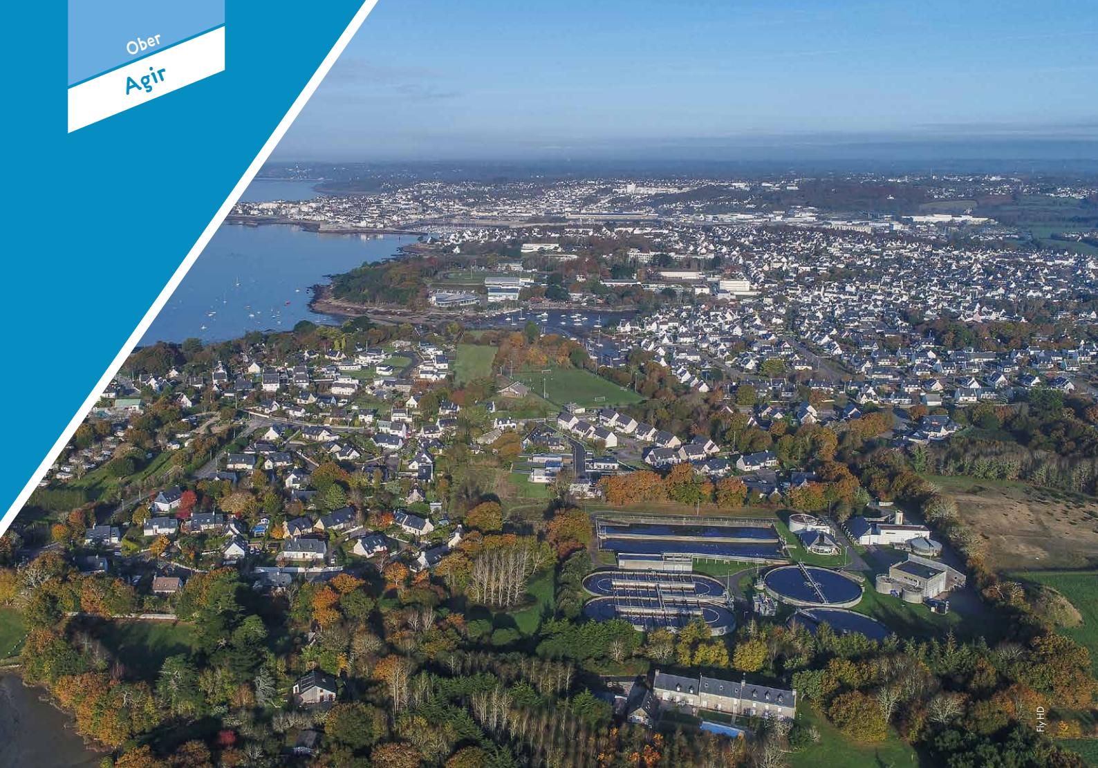
Au premier plan, la station d'épuration de Kerambreton.
