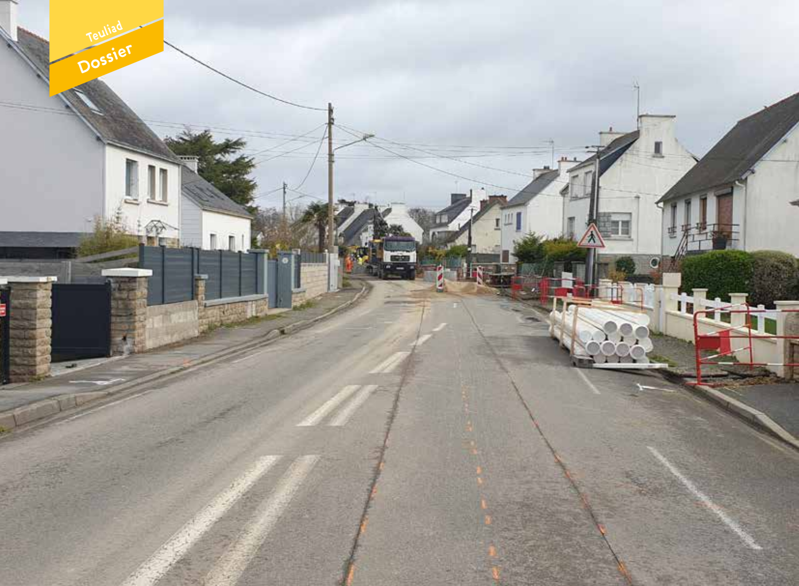
Rue de Kerviniou, les travaux de renouvellement des canalisations d'eau et d'assainissement ont démarré.
