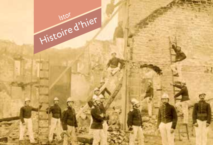
La compagnie des sapeurs-pompiers pose devant les ruines avec des échelles (1 er quart du 20 e siècle) - Archives municipales de Concarneau - 11Fi 1177
