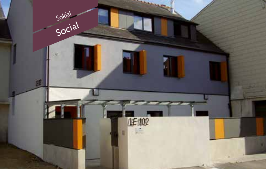
Le 102 après réhabilitation
